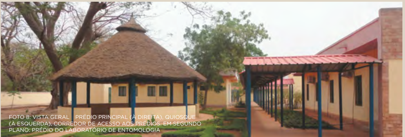
FOTO 7: PRÉDIO PRINCIPAL DO CENTRO COTTON C-4
